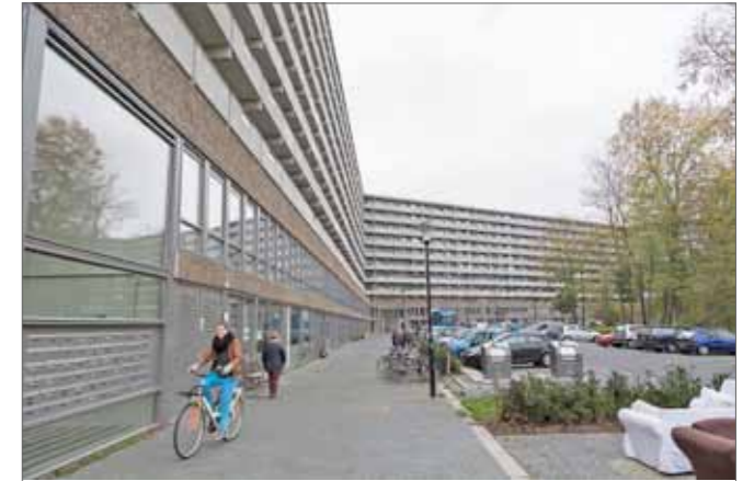
Renovatie Kleiburg "klusflat" Bijlmer NL Architects
