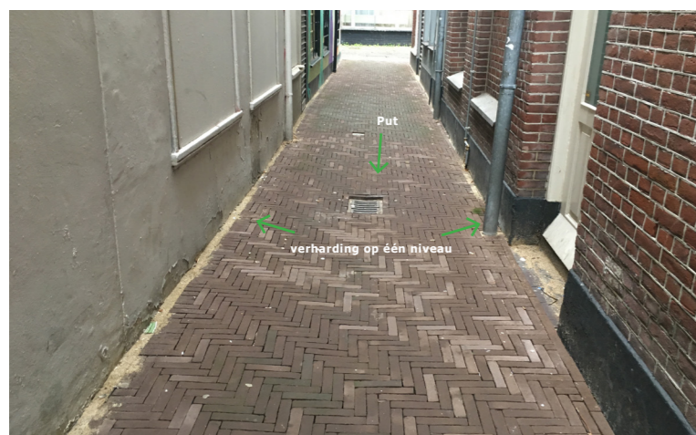
door het toevoegen van een straatkolk blijft vuilmetselwerk uit het zicht.
