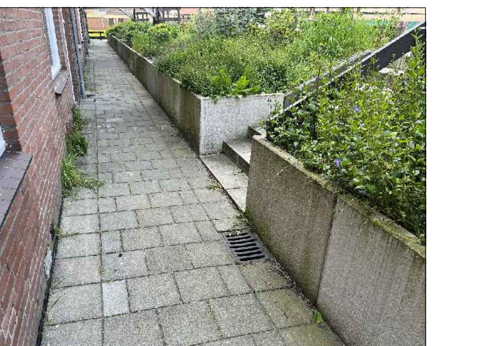
F3 (foto) damwandelementen langs woningen
