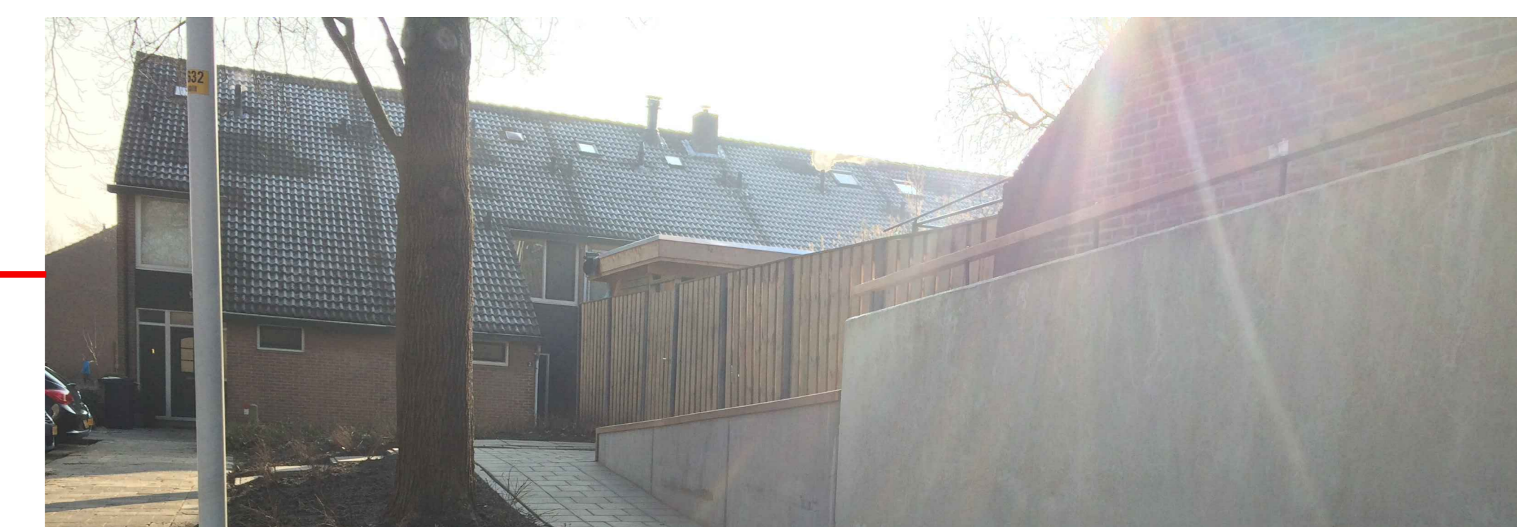
VOORBEELD KEERWAND INCLUSIEF HOUTEN DEKSLAAF
