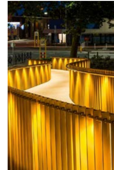
Begeleidende verlichting constructieve elementen Balustrades fietsbrug, plintgebouw en fietstrap
