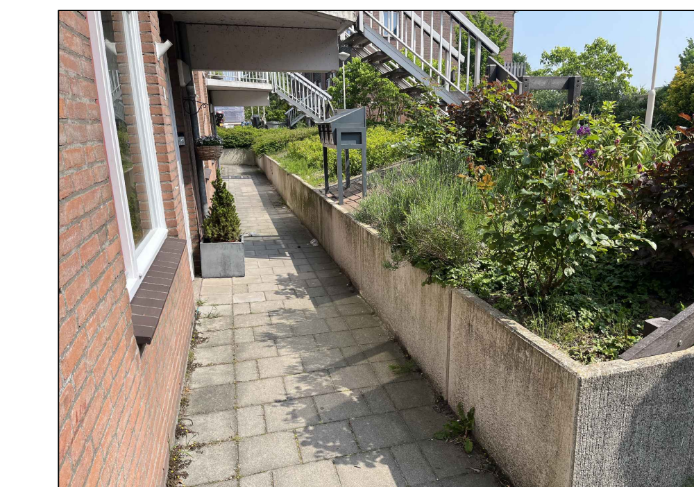
F3 (foto) damwandelementen langs woningen
