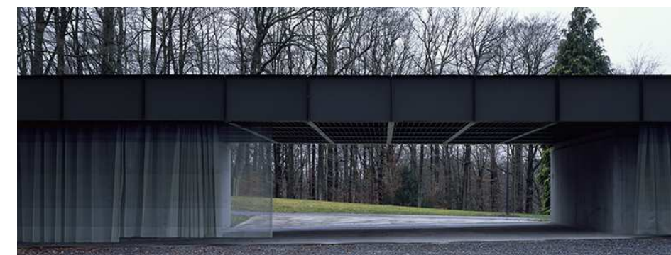
donker metalen luifelrand en houten constructie
