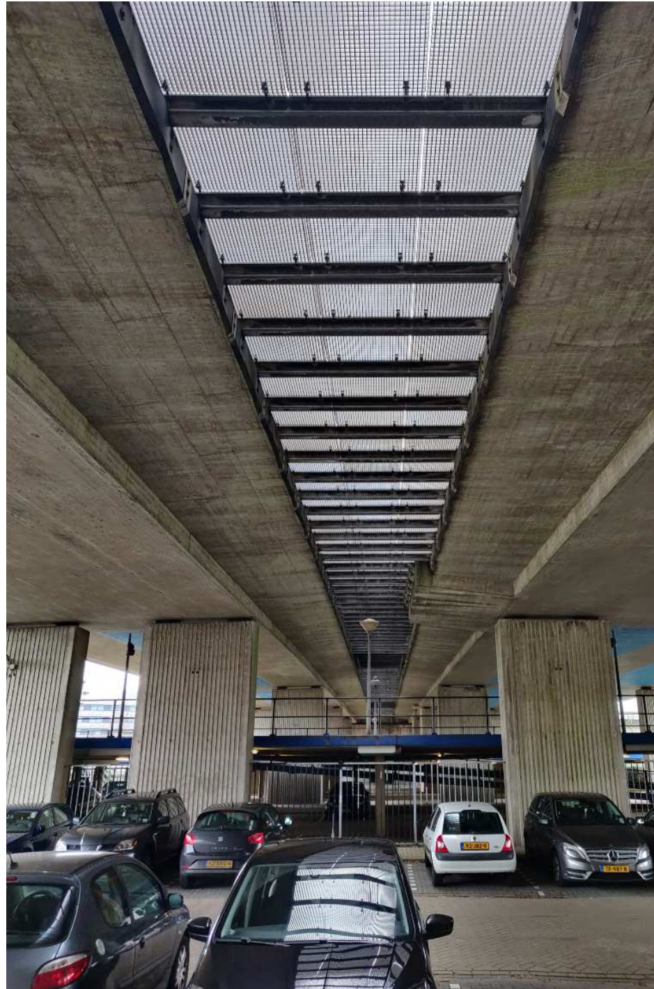
Robuust: onderzijde Afrikaweg ter plaatse van de Boerhaavelaan
