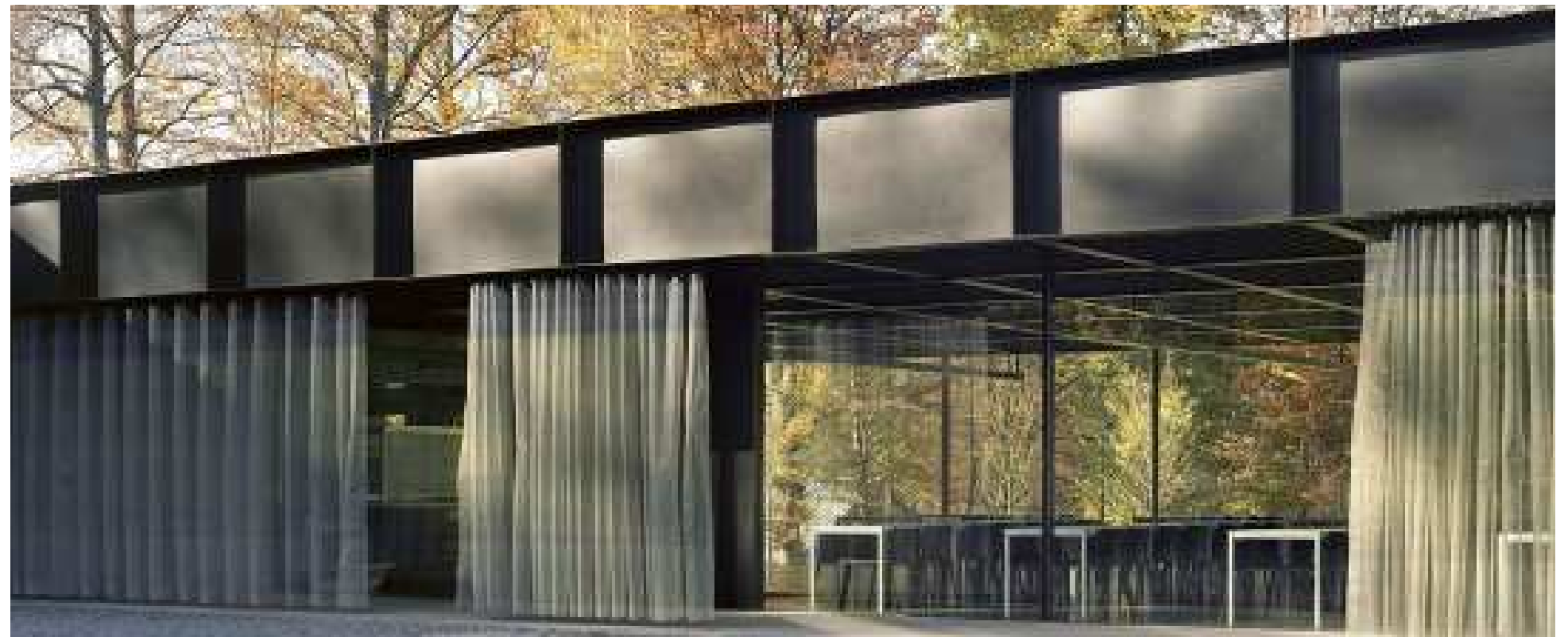
Donker metalen luifelrand en houten constructie, Polyvalent Infrastructure, Baukunst architecten
