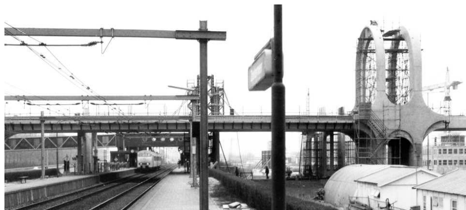
Foto Nelson Mandela brug tijdens de bouw (bron: Ramon Vasconcellos)
