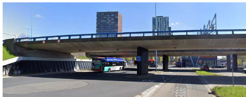
G. Afrikaweg Noord viaduct
