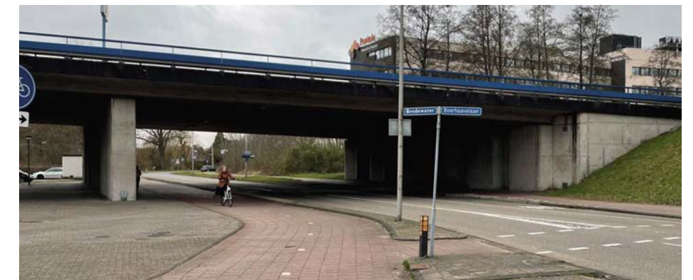
F. Afrikaweg Zuid viaduct
