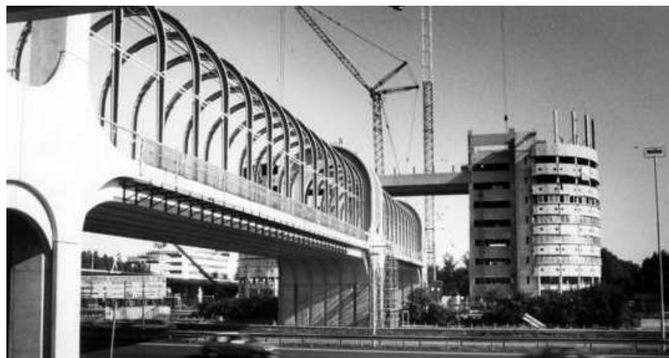
Foto Nelson Mandela brug tijdens de bouw (bron: AD)
