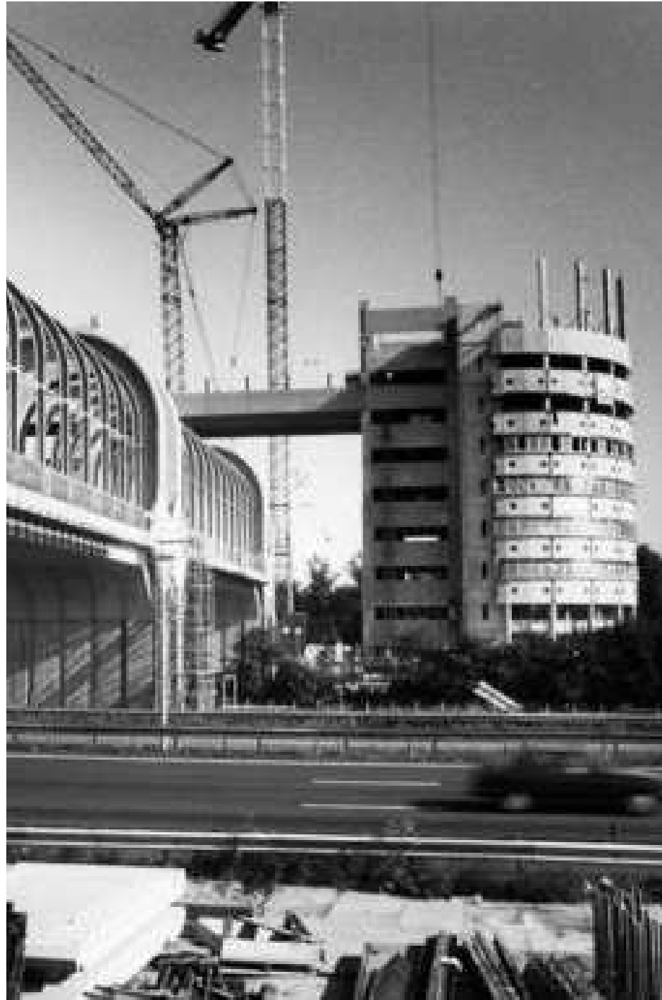
Poortgebouw tijdens aanbouw
